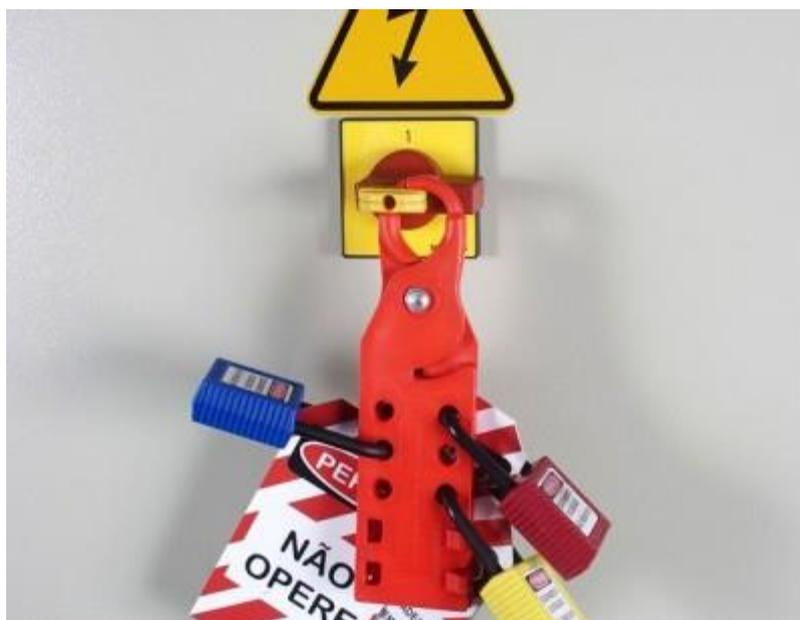
**Figura 4** – Bloqueio em painel elétrico com cadeados de operação, manutenção e segurança industrial. ([www.tagout.com.br](http://www.tagout.com.br))
