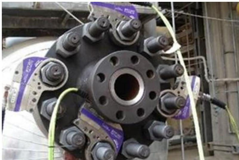
**Figura 12** – Aperto com ferramenta hidráulica. (<https://hytorc.com/hytorc-brasil>)
