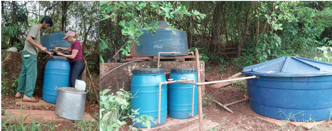
Figura 11 - (A) Instalação do filtro lento de areia, (B) filtro lento de areia instalado.
