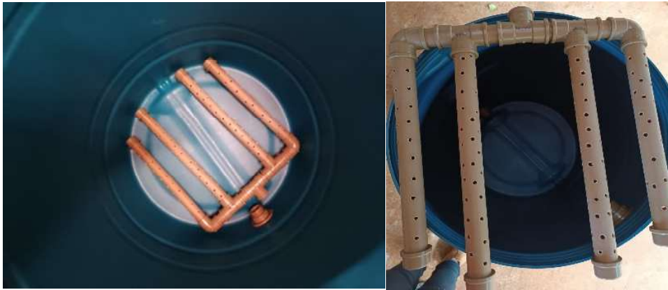
Figura 7 – Tubulação de saída do fundo do filtro.
