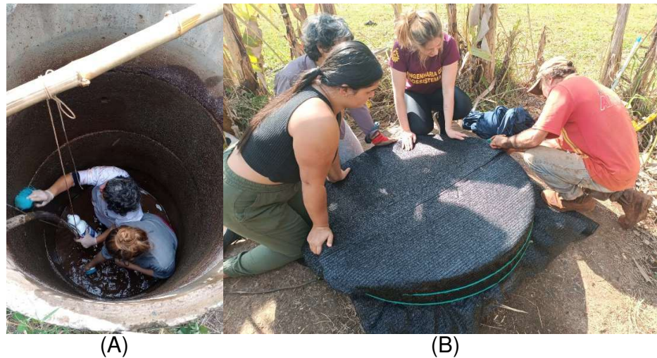
Figura 9 – Higienização e vedação do poço.
