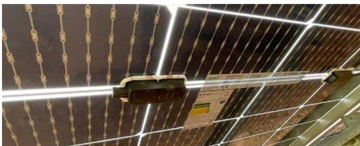
**Figura 5: Caixa de junção localizada atrás do painel**
